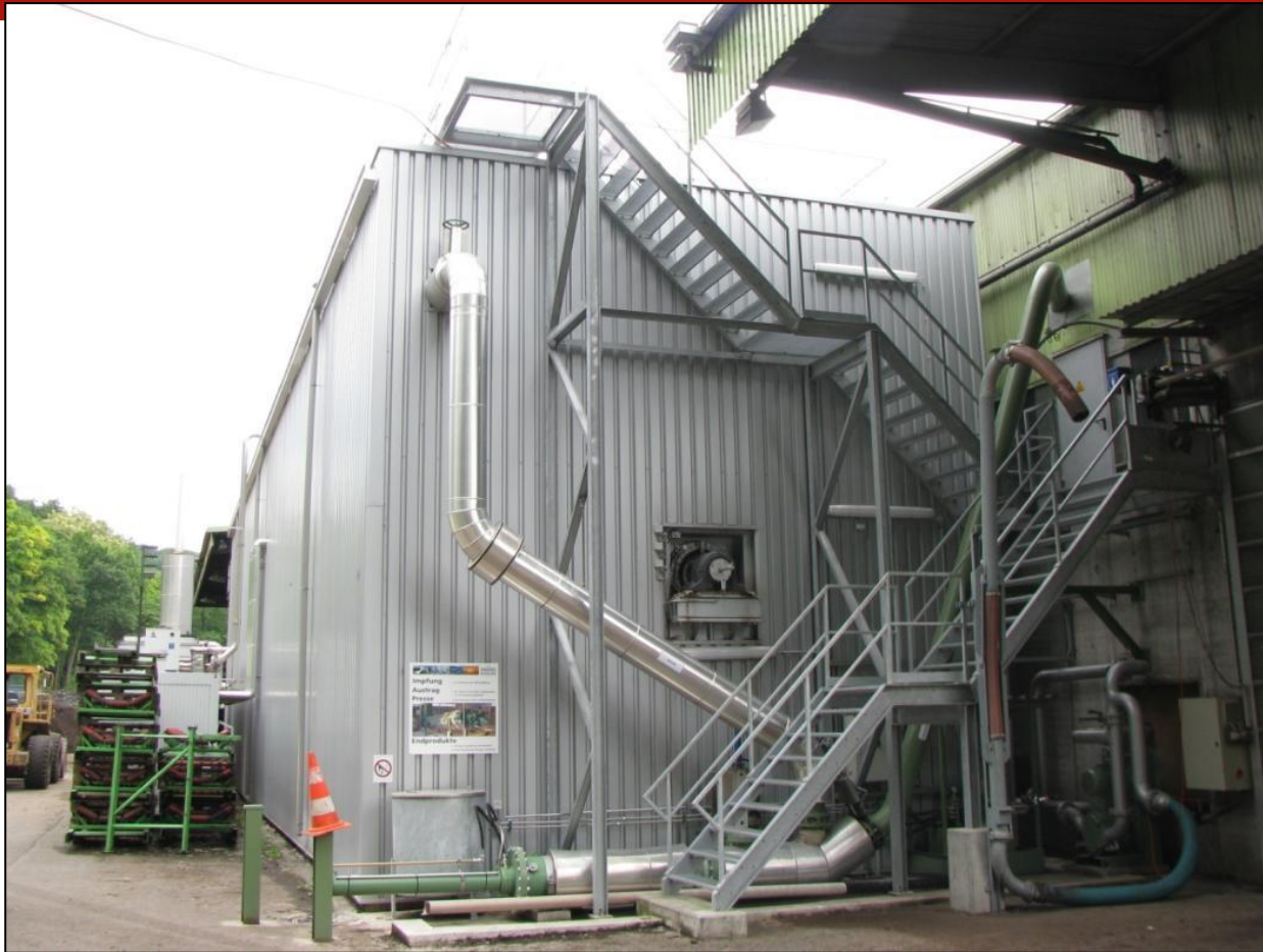
Fermentacja sucha odpadów zielonych Kompogas, Klingnau(Szwajcaria), foto proGEO
